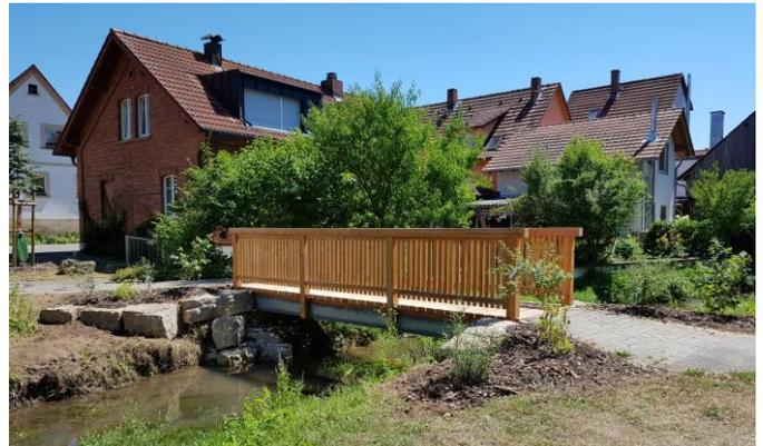
Als Konstruktion wäre zum Beispiel eine Anlage analog der Brücke in der Filzgasse denkbar, eine Kombination aus Stahl- und Holzbau, die unserer Ansicht nach sehr gut gelungen ist.
